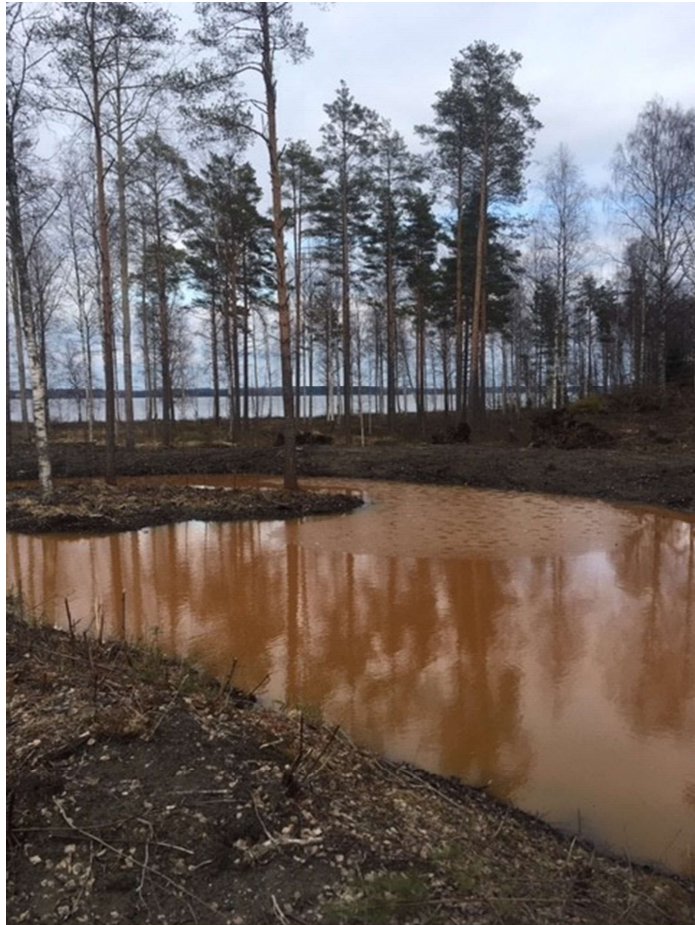
Hulevesikosteikon työt alkoivat vuonna 2019 ja viimeistely jatkuu vuonna 2020.
