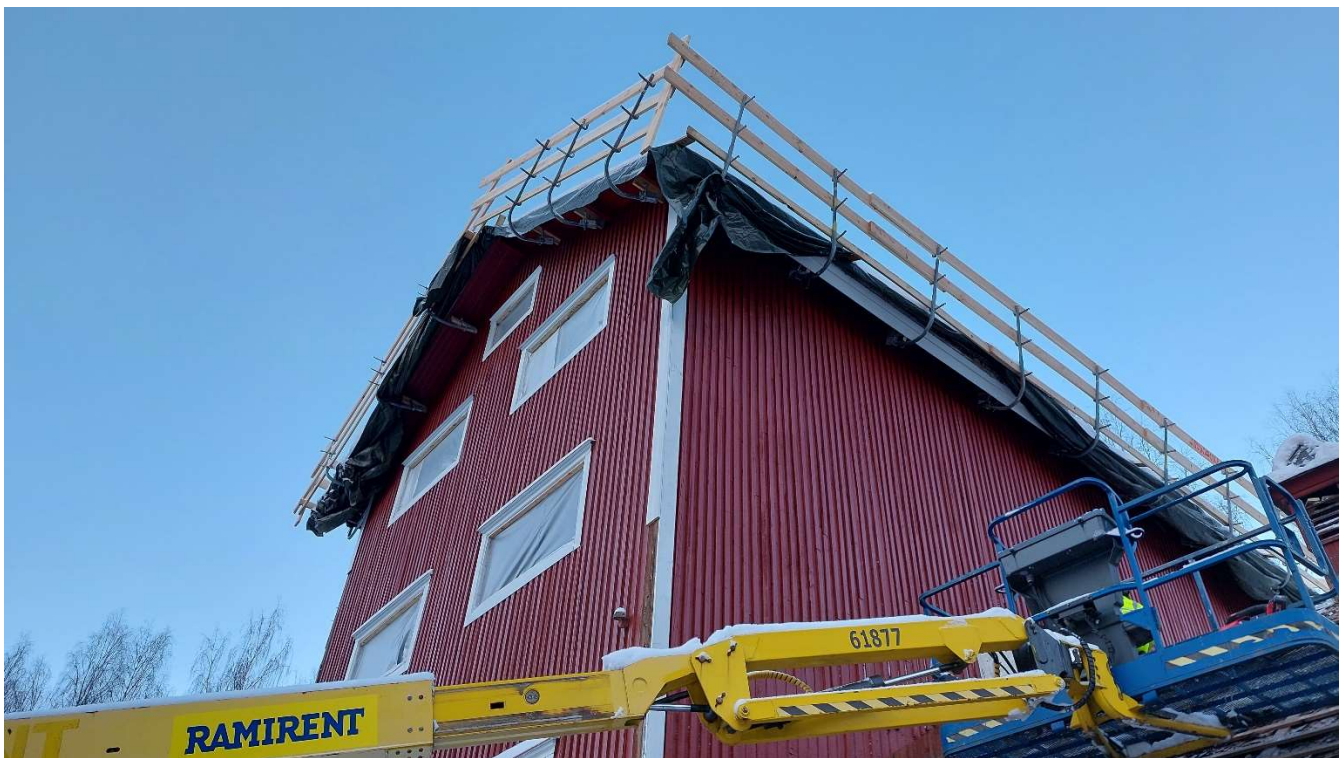
Puhoksen myllyn vesikatto uusittiin ja julkisivu maalattiin.
