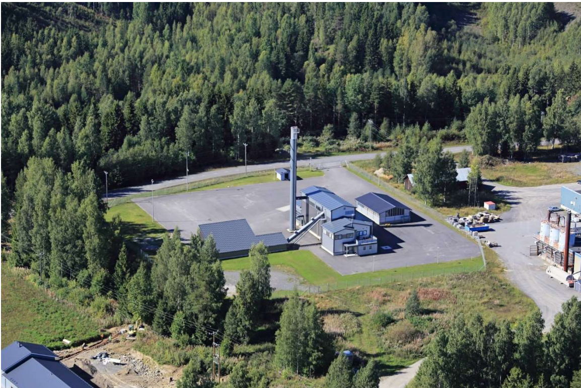
Kiteen Lämpö Oy:n Selkueen lämpölaitos valmistui vuoden 2011 alussa.
