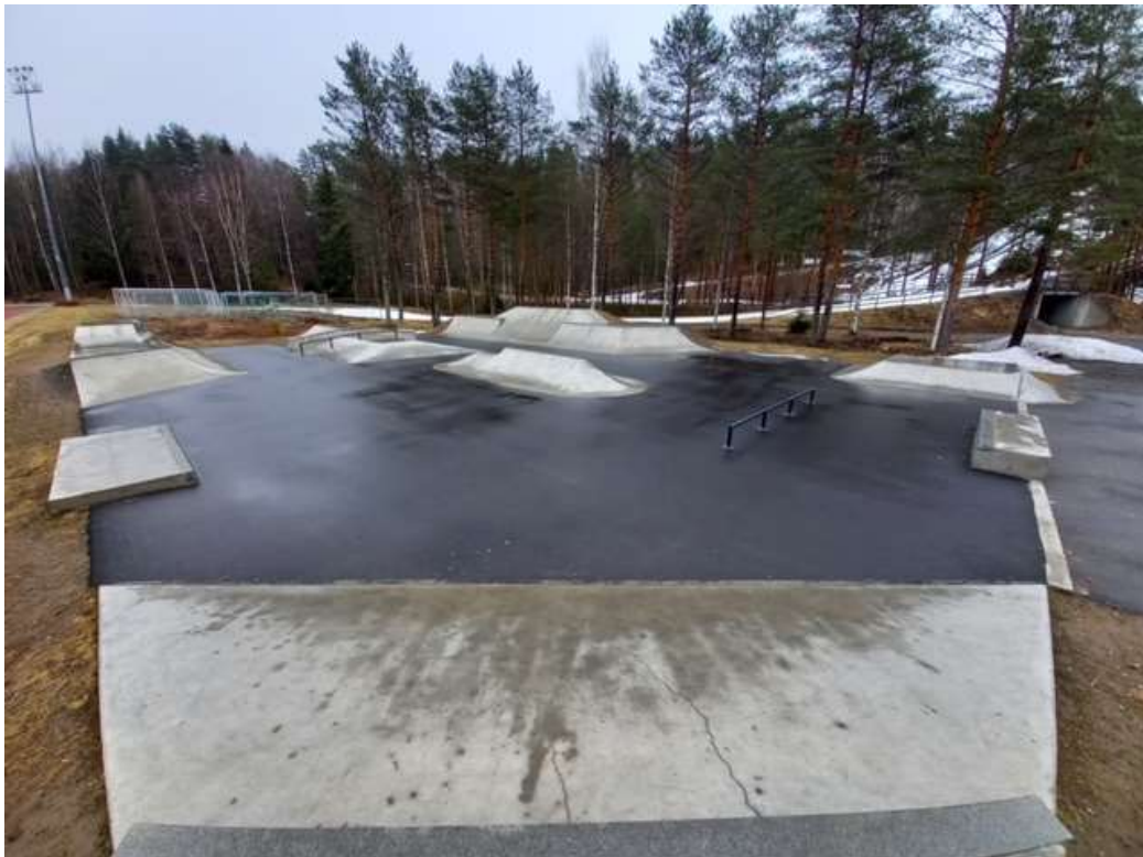
Hutsin skeittiparkkialue uusittiin vuoden 2020 aikana.
