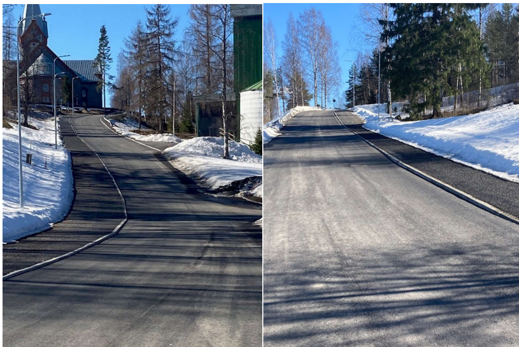
Meijerinrannan tieverkoston uusiminen (reunakiveykset ja päällystäminen).
