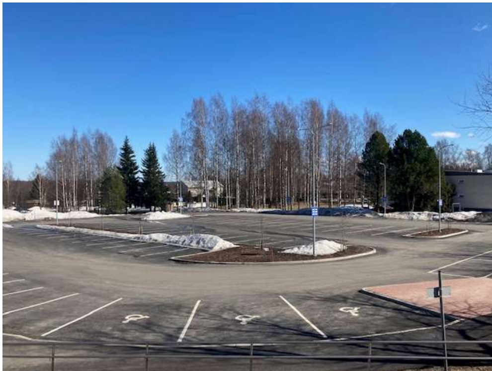
Ilmarisen parkkipaikan toinen vaihe valmistui kesällä 2020.
