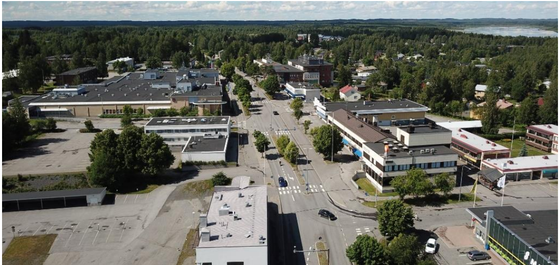
Kuva 26 Viistoilmakuva vuodelta 2020. Kuva on otettu Kiteentietä Kauppakulmalta Olkontien kohdalta pohjoiseen päin. Kuvassa erottuvat vasemmalla Yhdyspankin rakennus, Kupiaisen kauppakeskus sekä oikealla Osuuspankin rakennus.
