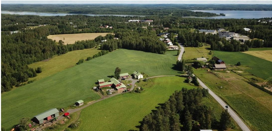
Kuva 34 Viistoilmakuva vuodelta 2020. Kuva on otettu Arppentien ja Kehätien risteyksen tuntumasta koilliseen, järvelle päin. Etualalla erottuvat maatilojen pihapiirit sekä Arppentie 11-19 talorivi.
