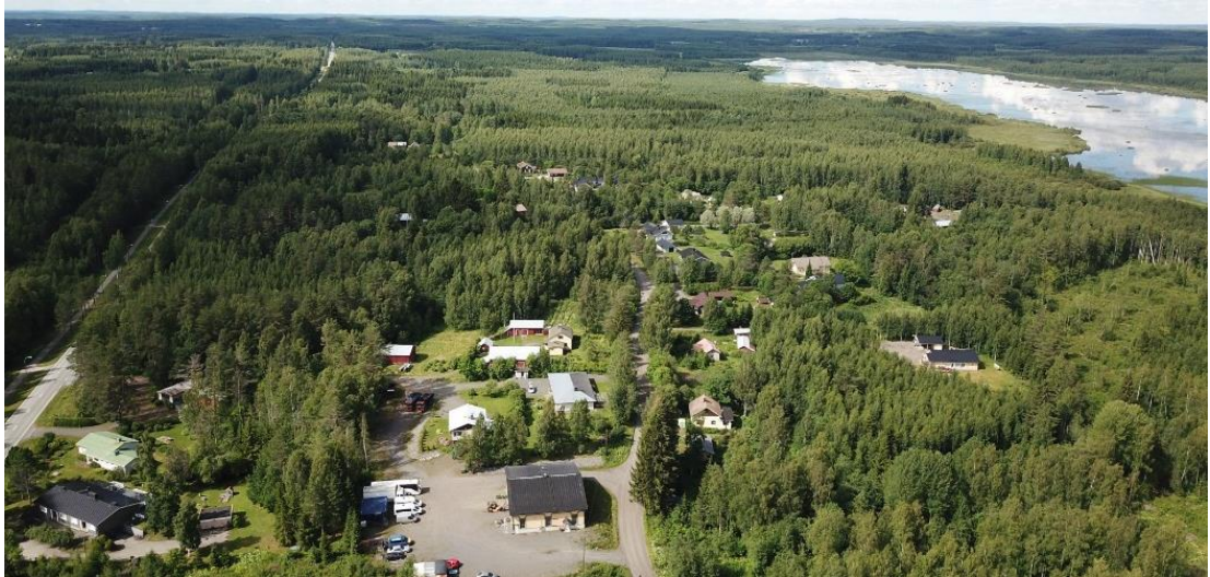
Kuva 17 Viistoilmakuva vuodelta 2020. Kuva on otettu Kiteentietä ja Maljakiventietä pohjoiseen päin.
